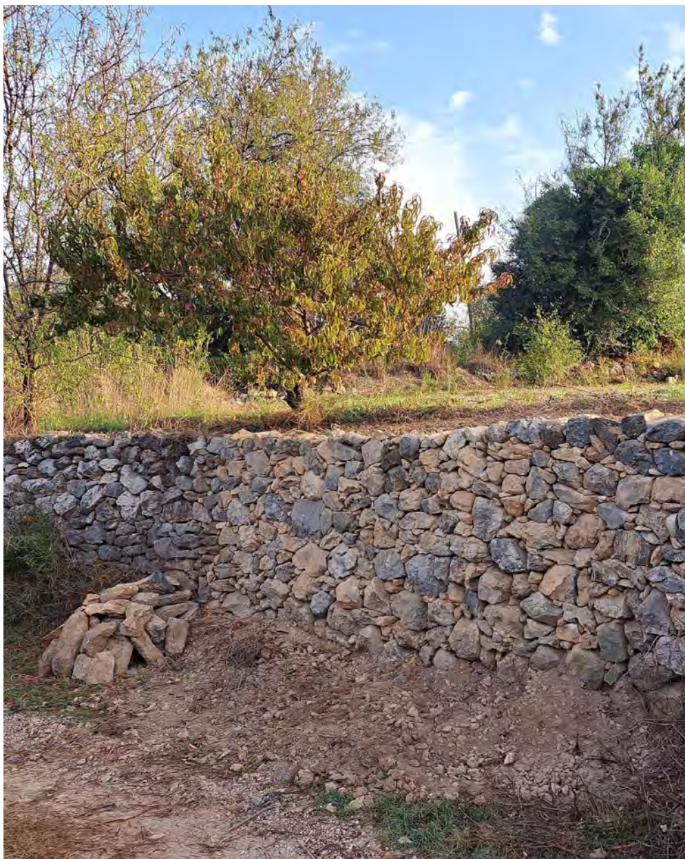
Tram d'una paret de feixa o de contenció recentment restaurat a Llers.
