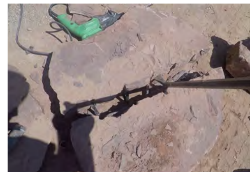
Seqüència de la partició d'una pedra de grans dimensions mitjançant ponciotti .
