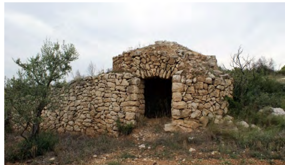
Barraca amb contrafort anular fins als muntants de la porta, a Avinyonet de Puigventós.
