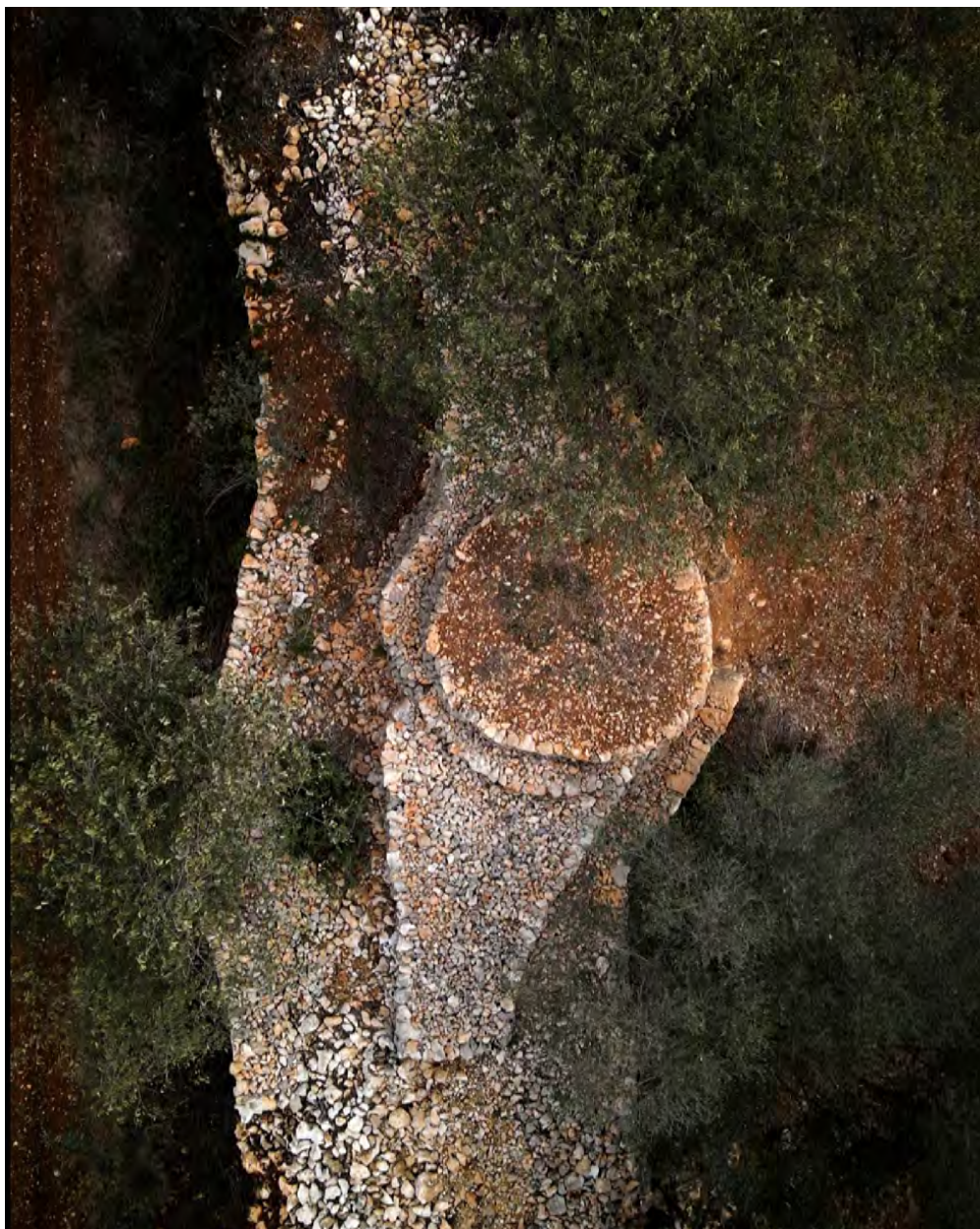
Vista aèria d'una barraca adossada a una paret separadora de gran amplada i dos grans contraforts que envaeixen la façana, a Llers.
