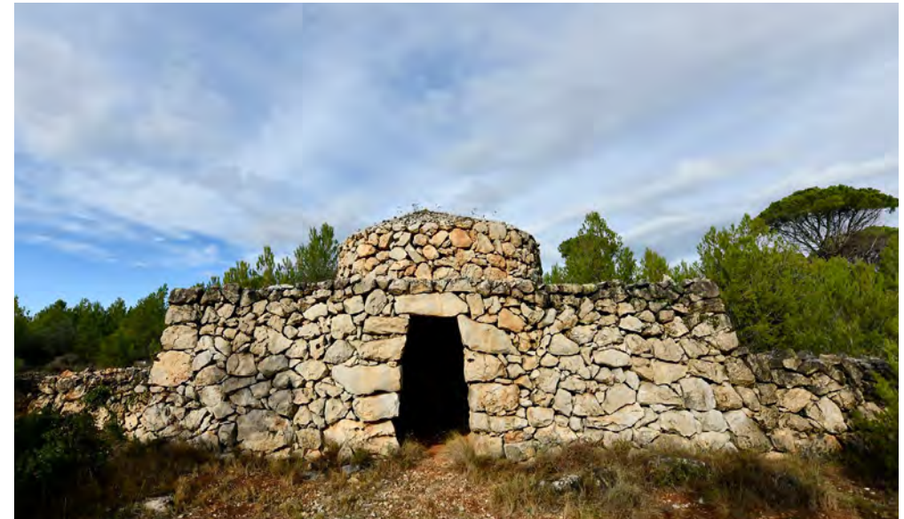
Barraca M-26, a Pont de Molins, amb paraments atalussats i contraforts fins a la porta, i monumental barraca V-57 a Vilanant, amb una façana de 7 m de llarg recolzada en una paret.
