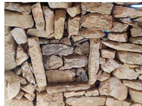
Fornícula amb la llinda partida i, a la imatge inferior, farciment preventiu de la fornícula amb pedra.
