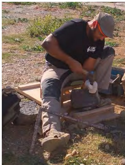
El treball de la pedra no es fa mai sobre la paret, per tal d'evitar posar en risc les pedres prèviament col·locades.
