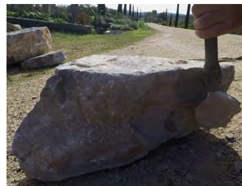
Eliminació d'una protuberància de la pedra amb el topo (o escafilador) i la maceta.
