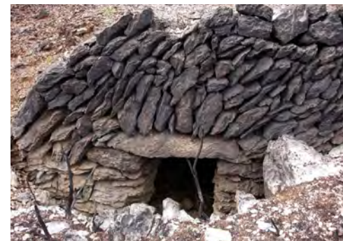
Barraca ubicada dins una rasa a Pont de Molins, construïda amb rastell tant a l'interior com a la volta. Concebuda com a amagatall. Probablement té un origen militar.
