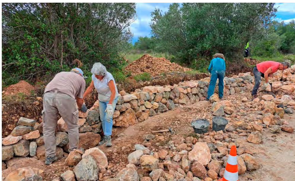
Preparació de la base del fonament d'una paret de pedra seca a Pont de Molins amb l'ajuda de maquinària i treballs de restauració de la mateixa paret.
