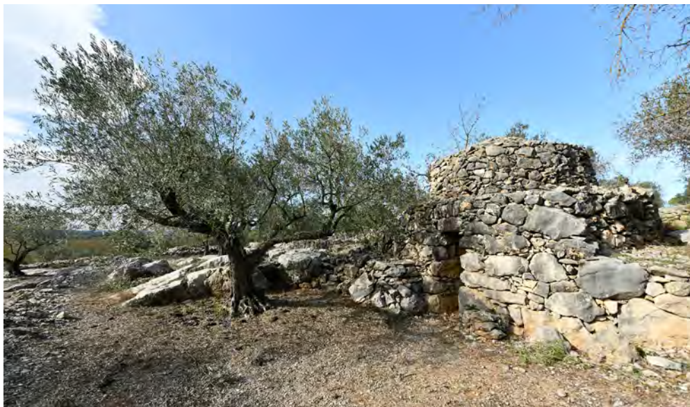
Barraca B-68 a Biure, amb contrafort perimetral i dues fileres de parament en rastell sobre la porta, i A-73 a Avinyonet, amb una de les barraques més altes del terme, amb una alçada de volta de 4,15 m.
