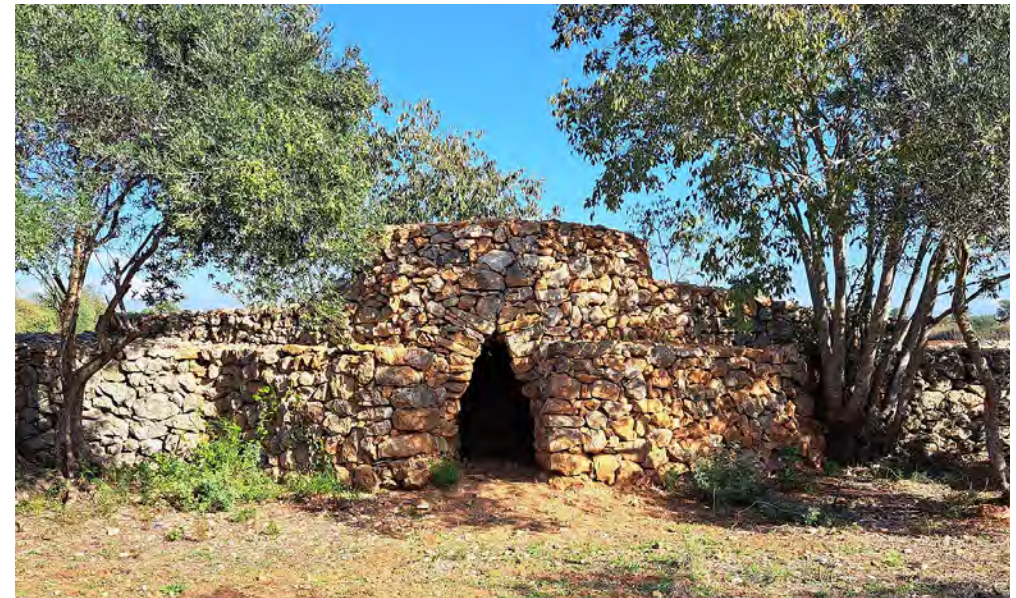
Restauració de la barraca L-53, després del despreniment de la façana i part dels contraforts frontals.
