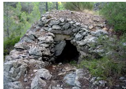
Barraca de Biure coneguda com «La tomba», construïda a finals del XVII o primera meitat del XVIII. Es tractaria d'una de les construccions agrícoles de falsa volta més antigues de Catalunya.
