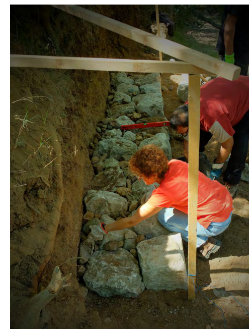
Construcció del fonament d'una paret de feixa a Biure.
