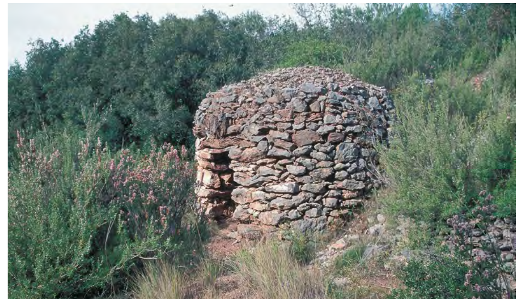
Barraca A-18 a Avinyonet de Puigventós, amb dues corones i escala exterior, a mode de contrafort, d'accés a la coberta, i barraca B-6 a Biure, la única de la Garriga amb la porta sostinguda per un cabiró d'olivera.
