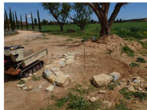
Pas a pas de la construcció d'una petita barraca de nova planta. Marcatge de la planta de la barraca i col·locació de la primera filada del fonament, amb obertura de la porta a la part frontal de la imatge.
