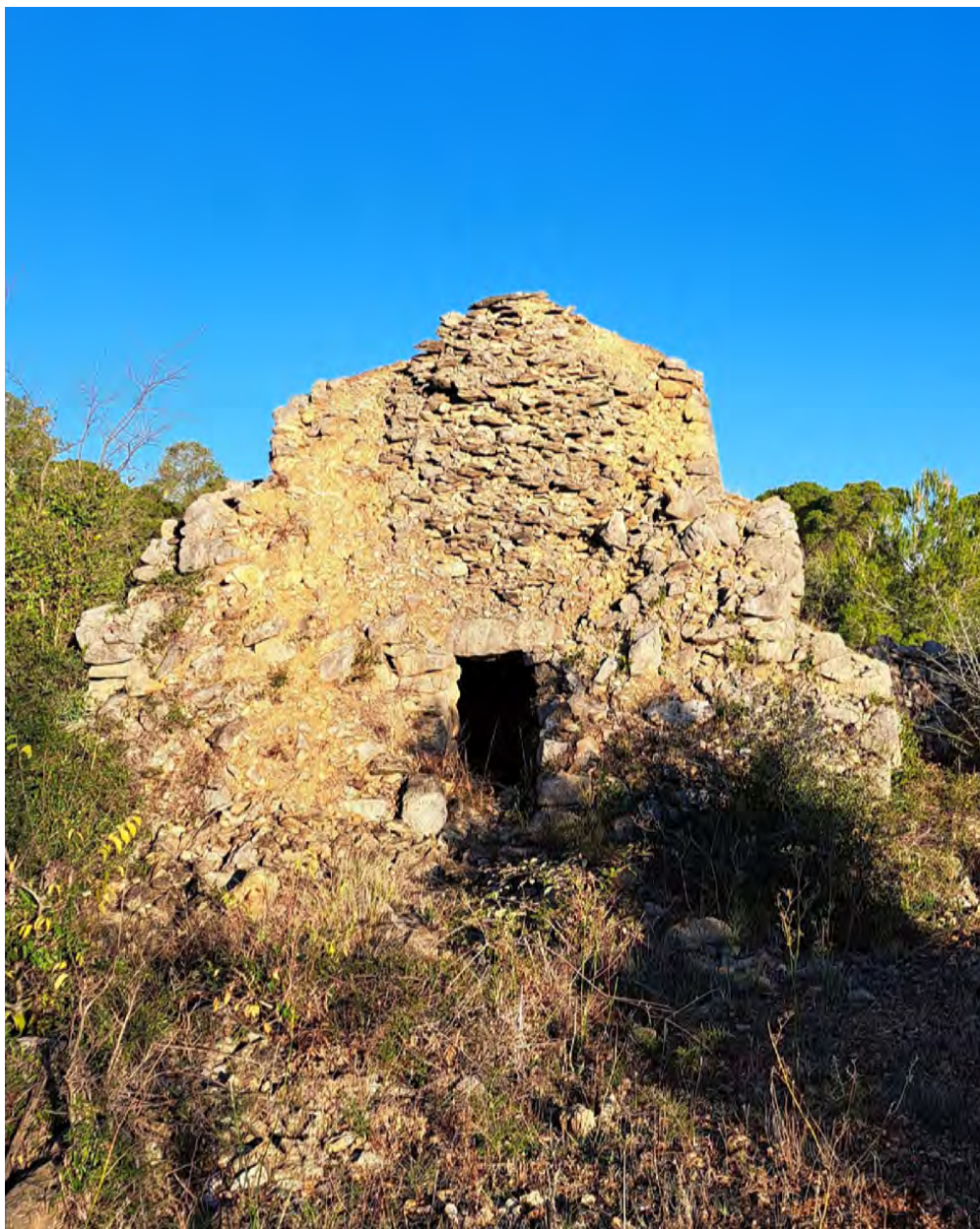
Barraça d'en Rotllens, a Vilanant. Amb una volta de 455 cm d'alçada interior i una volta de 375 cm, es tracta d'una de les barraques de major envergadura de la Garriga d'Empordà.
