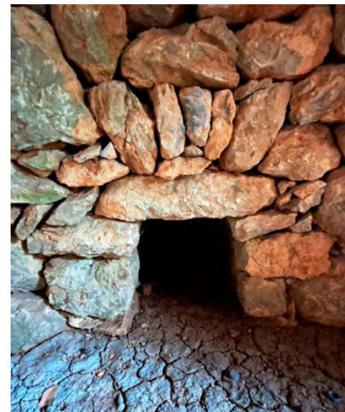
Cocó molt ben estructurat, amb muntants, llinda i arc de descàrrega superior.
