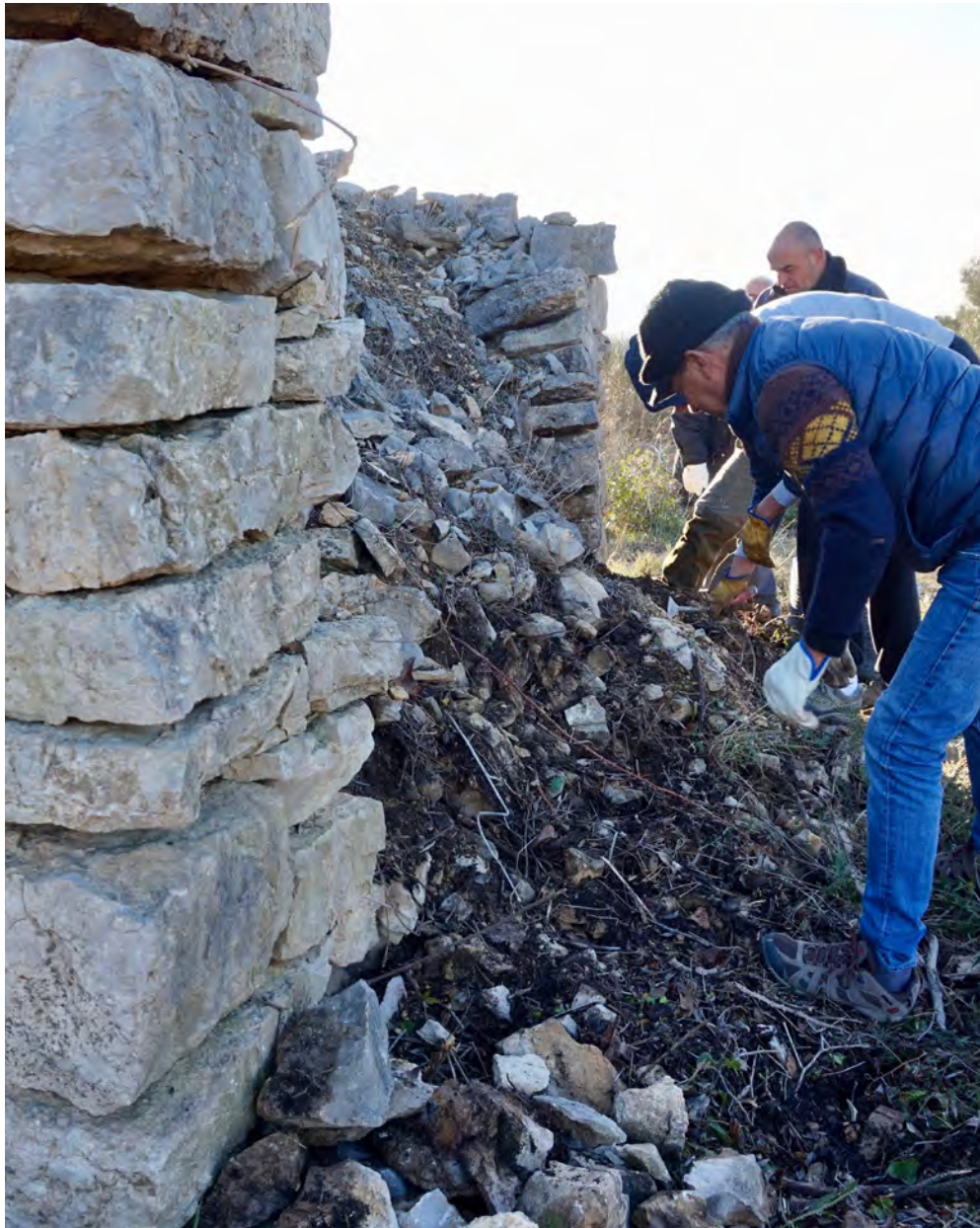
Voluntaris realitzant tasques de desenrunament manual en una esllavissada lateral d'una barraca.
