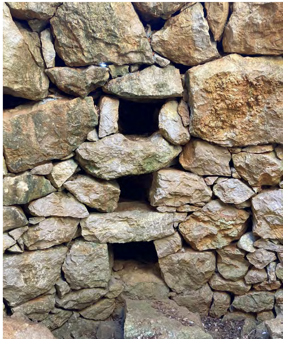
A Avinyonet de Puigventós trobem l'excel·lent cas de la barraca de pedrera A-79, datada l'any 1865, amb un total de vuit fornícules, sobreposades en fileres de dues i de tres.
