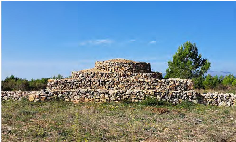
Restauració de la barraca L-28, amb recuperació dels perfils posteriors de la barraca.
