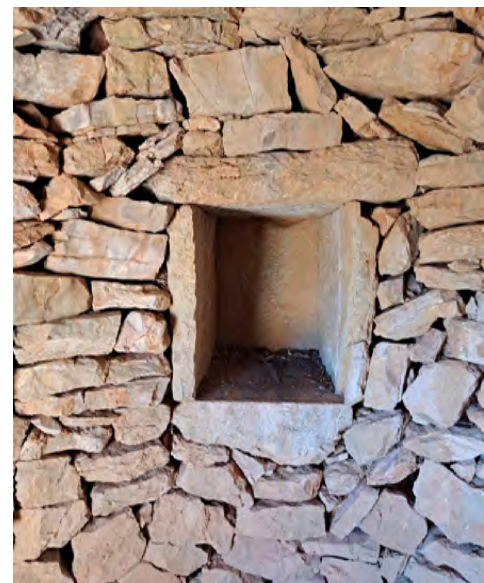
Fornícula de grans dimensions en una barraca de picapedrer.
