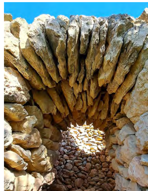
Corredor amb arcs consecutius en una barraca ensulsiada de Llers i corredor amb llandes a Vilanant.
