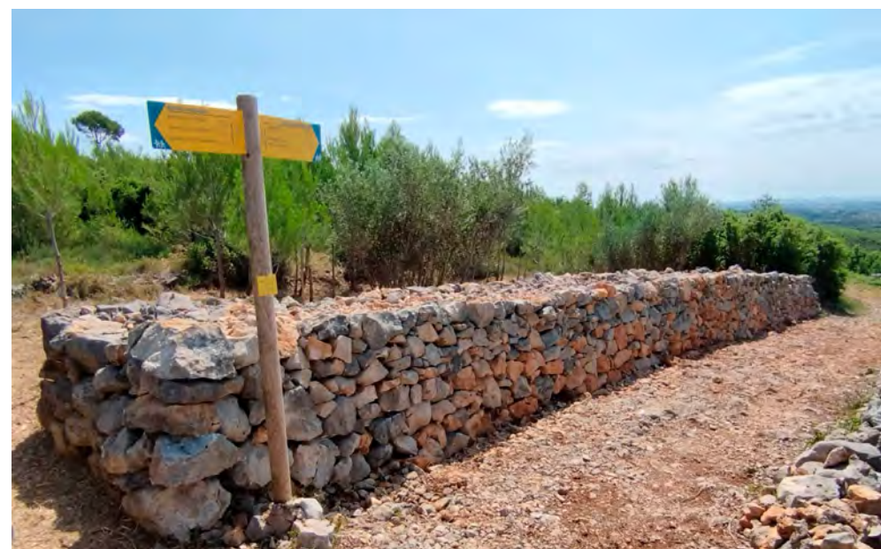
Restauració d'una paret de partió a Vilanant.
