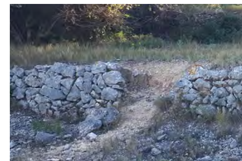
Paret de contenció amb una esllavissada provocada pel pas d'animals i persones. La pedra de l'esllavissada ha quedat disseminada pels voltants.
