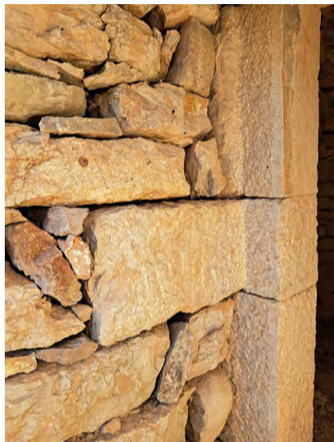
Pedra carejada i repicada en contrast amb la pedra buixardada dels muntants interiors de la porta.
