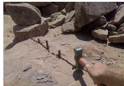
Seqüència de la partició d'una pedra de grans dimensions mitjançant ponciotti .
