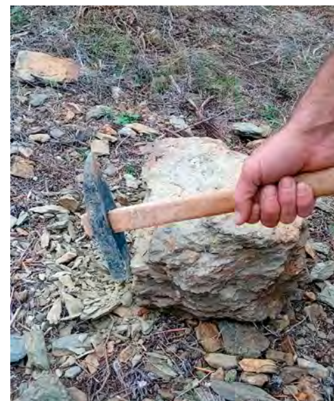
Eliminació d'una protuberància de la pedra amb el martell de marger.
