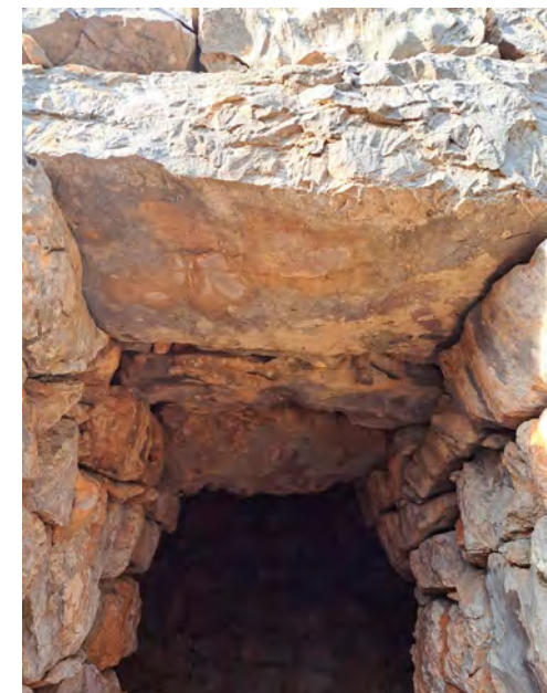
Corredor amb arcs consecutius en una barraca ensulsiada de Llers i corredor amb llandes a Vilanant.
